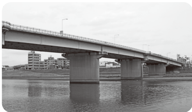
耐震補強が完了した新鶴見橋
