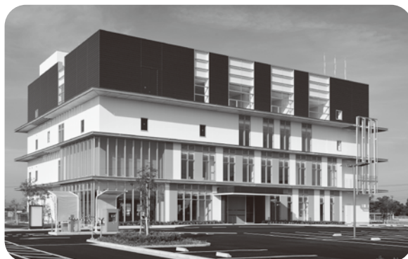
12月24日から移転開設される南区役所
