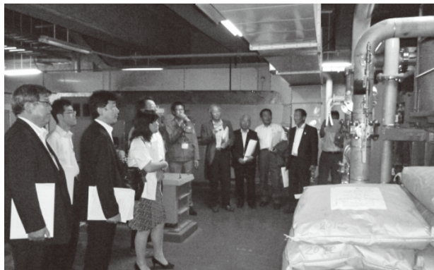
下水処理施設を調査（苫小牧市）
