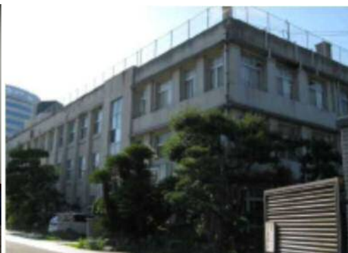
演習の題材 (旧内山下小学校跡地)
