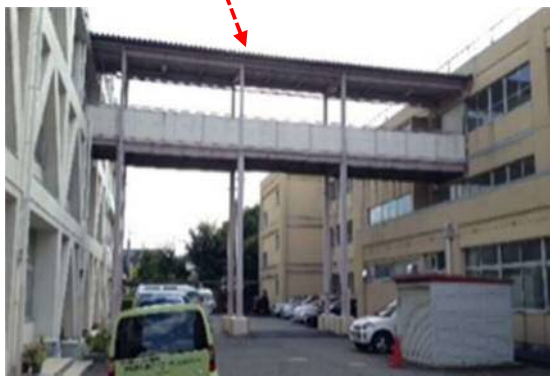
二つの棟の3階部分を繋ぐ渡り廊下
