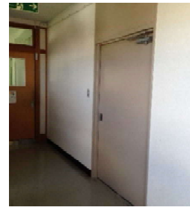
階段前に扉を設置し施設を分離
