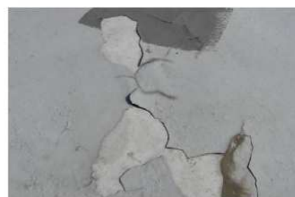
防水層の破損
