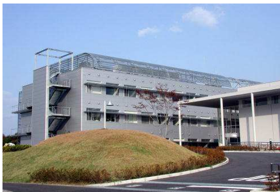
屋根の設備類を丸みのあるルーバーによって修景し、建築物と調和させている
