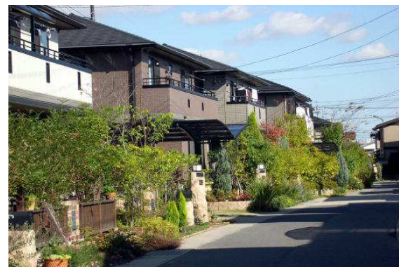
ファサード部の植栽により周辺の住宅との緑のつながりをつくっている
