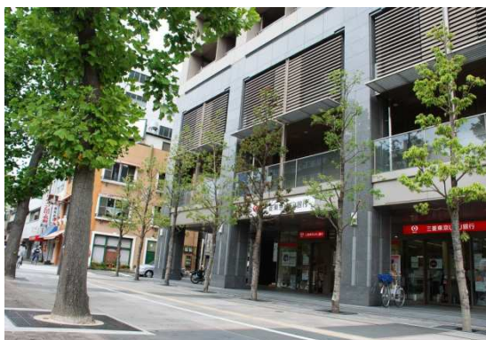
建物3階に駐輪場を設け、化粧ルーバーにより修景し、建物と一体的にデザインしている
