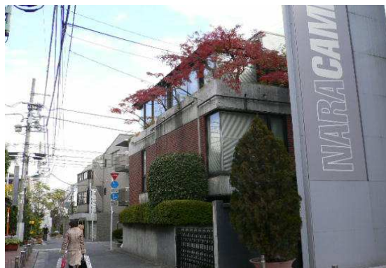
敷地内緑化、屋上緑化などにより屋外設備を修景し、街並みに配慮している
