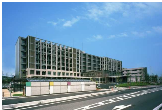
構造補強が新しい構造美を創出している
