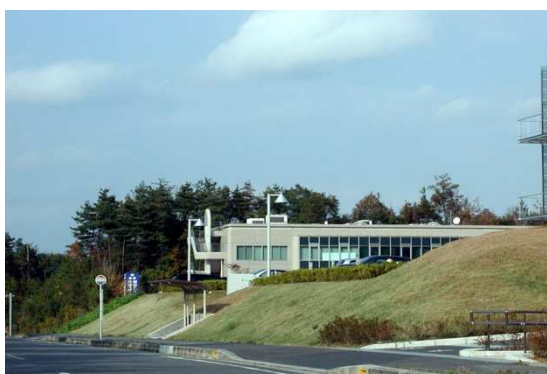
擁壁を設けなくて、緑地の法面によりできるだけ威圧感を抑え、良好な景観を演出している
