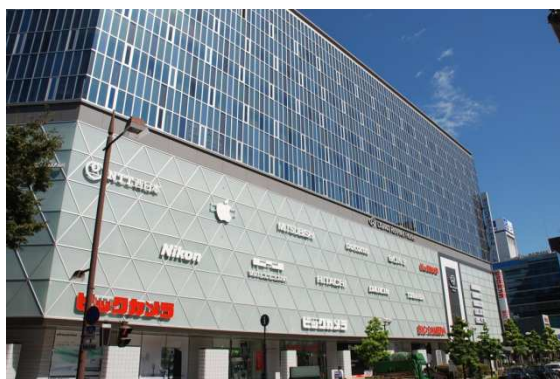
壁面広告物を建築物外壁の色彩やデザインと調和させている
