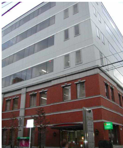
上層部の壁面の色をラインや窓縁として下層部に使用し、色彩の工夫をしている
