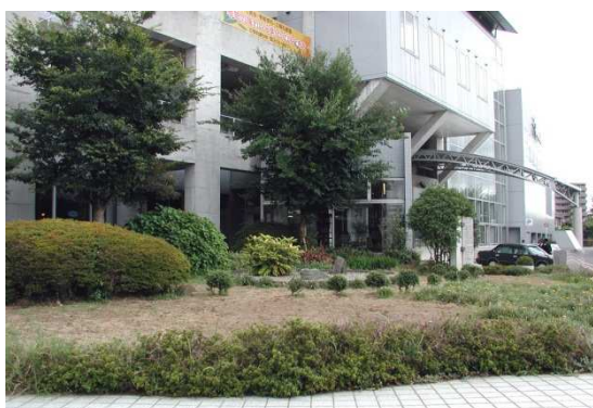
境界構造物を設けず、見通しの良い緑地により、開放的な空間となっている
