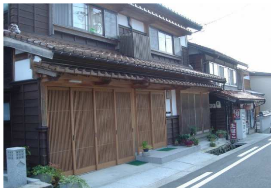
屋根上の室外機を化粧格子で修景することで歴史的街並みに配慮している
