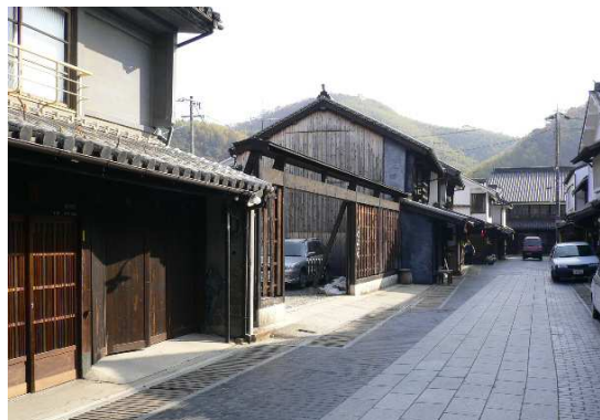
駐車場の境界に板塀を設け、修景することにより街並みに配慮している
