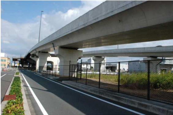
高架橋の上部工と下部工が一体にデザインされ、曲線が構造物の厳つさを和らげている
