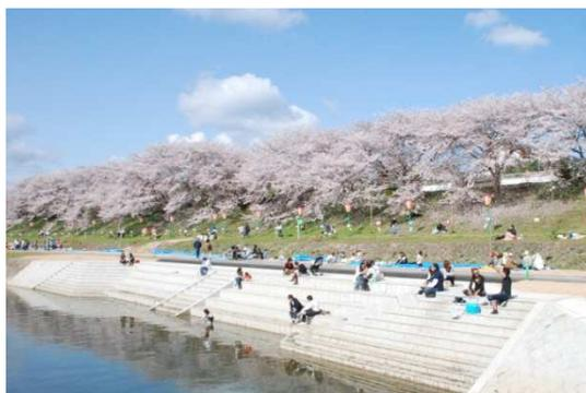
階段の設置により親水性に配慮した護岸整備
