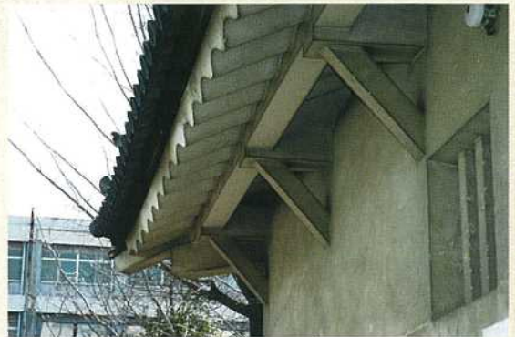
総白壁の外観
