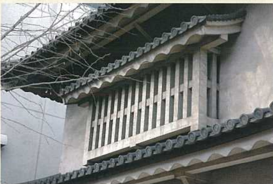
二階格子窓の外観
