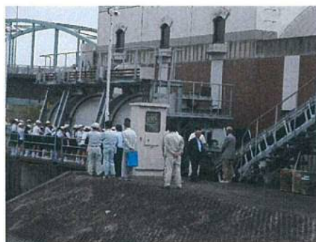
七区用排水機場での除塵機運転説明
