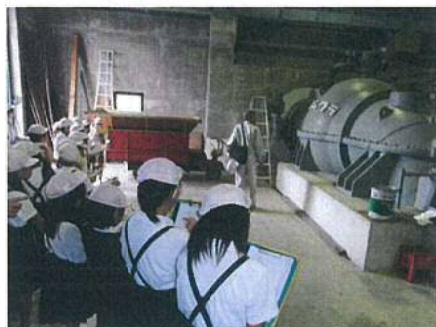
七区排水機場内でのポンプの説明
