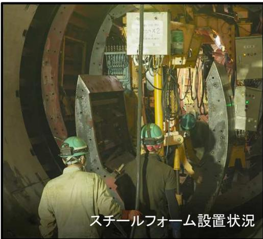
トンネルの形に合わせて型枠を設置します。
