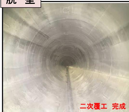
コンクリートが固まったら型枠を外します。
