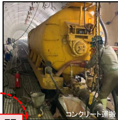
コンクリートをトンネルの中まで運搬し、型枠とトンネルの間にコンクリートを流し入れます。
