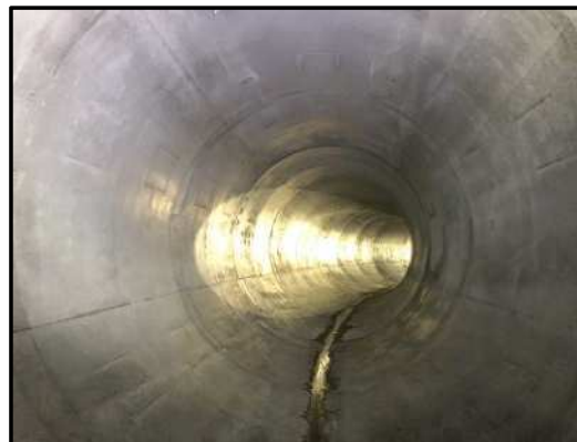
写-1 完成した雨水管内
