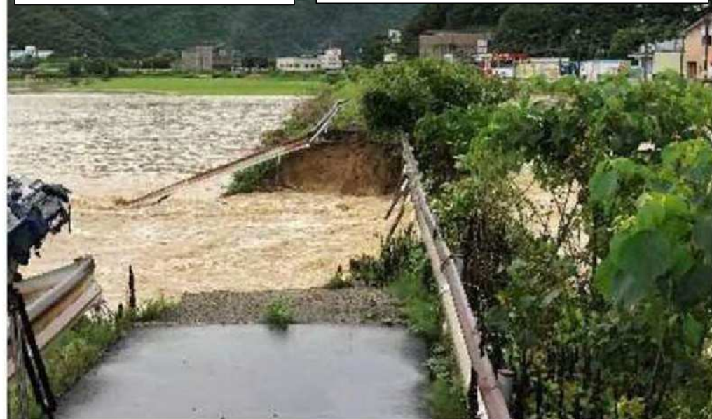
令和3年 7月豪雨 広島県三原市 沼田川破堤
