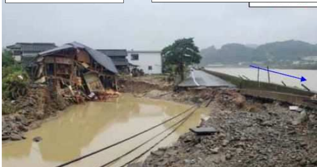
令和2年 7月豪雨 熊本県人吉市 球磨川破堤
