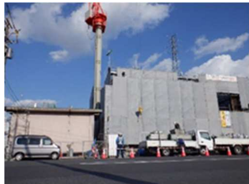
写真2-2-6 岡南ポンプ場（新設）
