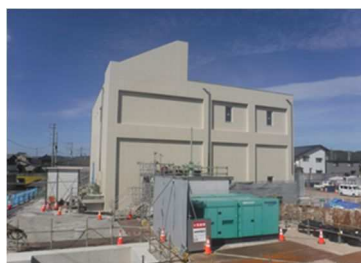
写真2-2-3 今保ポンプ場
