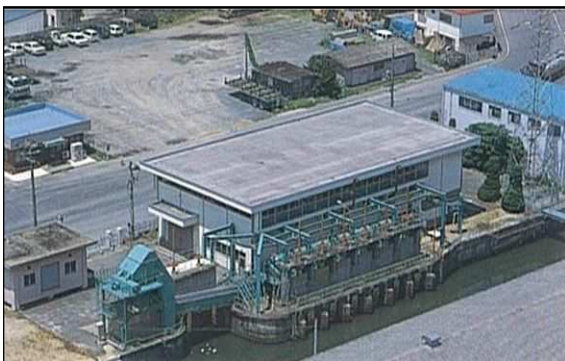
写真2-2-5 岡南ポンプ場（既設）
