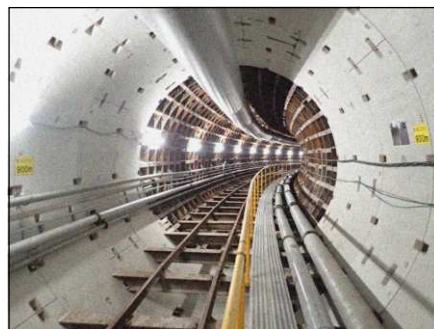
写真2-2-2 一次覆工完成
