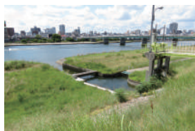
旭川(倉安川排水樋門)
