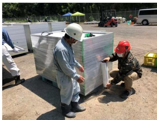
外観検査、選別作業 発生現場にてパレット積み
