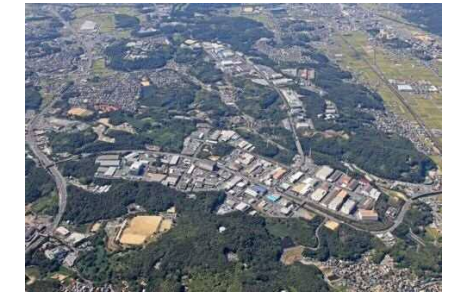
■岡山県総合流通業務団地
