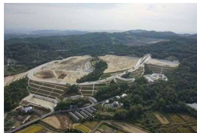
■造成中の空港南産業団地
