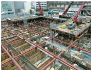
▲地下工事の状況 (令和6年3月中旬時点)
