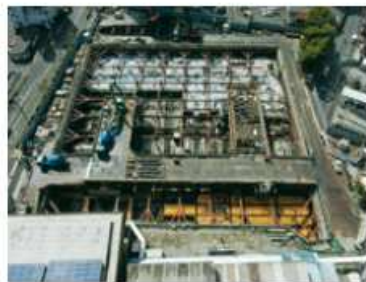
▲工事現場の様子 (令和6年3月末時点)
