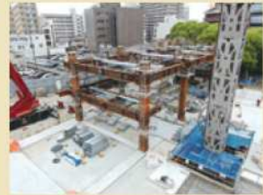
▲組み上がった地上部分の鉄骨 (6月中旬時点)
