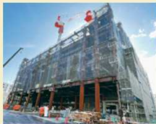
▲鉄骨の組み立て状況 (令和6年10月時点)
