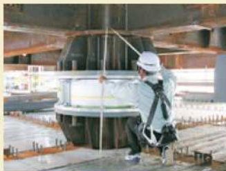
▲免震層に設置した免震装置 (令和6年9月時点)
