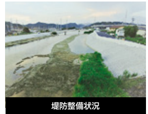
堤防整備状況
