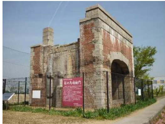
桜の馬場樋門
