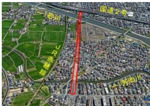
市道西大寺上中川町1号線整備状況
