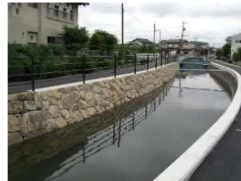
護岸整備後の倉安川
