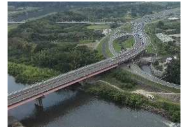
主要地方道岡山吉井線 (新大原橋拡幅)
